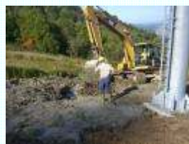
基礎周りの土を埋め戻して工事を終了
