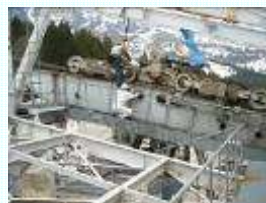
搬器走行装置の点検
