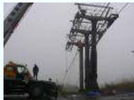
旧ワイヤロープを新品と交換のための引き回し作業
