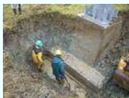
基礎の掘り出し作業を開始
