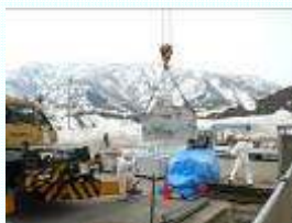
減速機オーバーホールのため搬出
