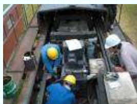
電動機解体準備
