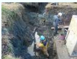
排水対策で暗渠パイプを増設
