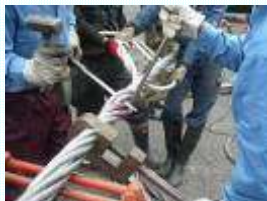
新しいワイヤロープのジョイント作業
