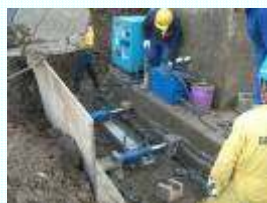
油圧ジャッキで基礎を山側や横へ移動
