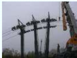
ワイヤロープのジョイント終了後、線路に戻し工事完了
