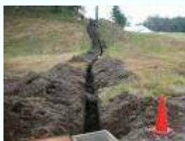
保安通信ケーブルの更新
